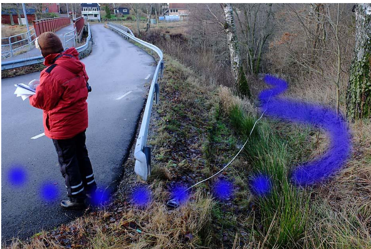
Bild 11. IGNITA 2014. Fiskvägens kulvert mynnar ut ungefär vid nuvarande bilvägsräcke. Fiskvägens placering avgörs av dammkroppen med hänsyn till dammsäkerhet. På nedströmssidan om dämnet planeras fiskvägen gå öppen (heldragen blå linje) ca 50 meter.
