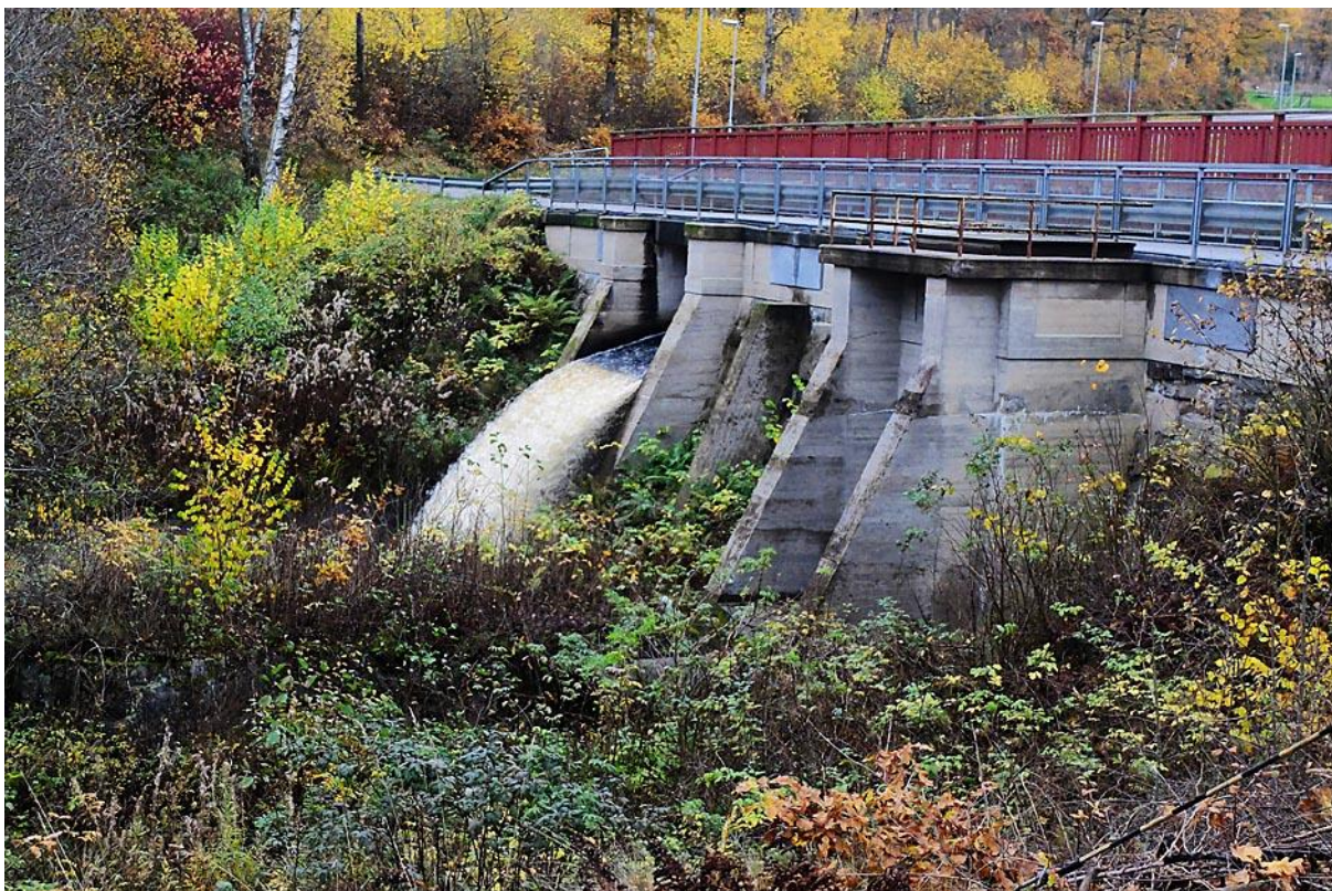
Bild 5. IGNITA 2014. Hältopssjöns damme. Flodutskovet, där den fria vattenmassan passerar, ses till vänster. Det före detta utskovet till turbinen, det s.k. tubintaget ses till höger och är numera igengjutet.
