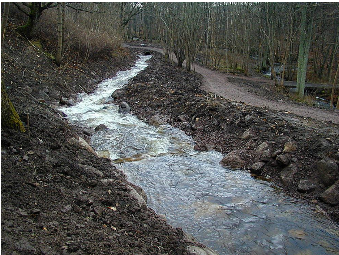
Bild 8. IGNITA 2001. Fiskväg vid Hjoån, med 10 -12 % lutning. Den är nyanlagd innan vegetationen etablerat sig.
